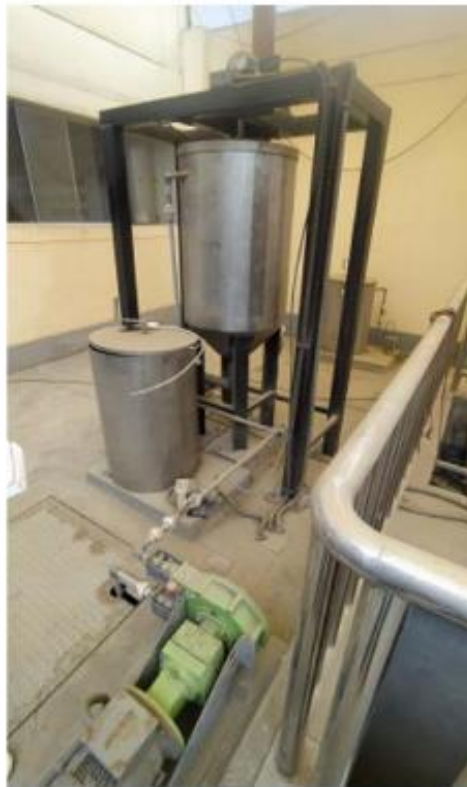
Fig. 4: Tanque de preparación de insumo químico con bomba peristáltica
