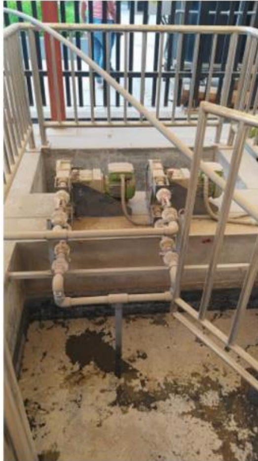
Fig. 1: Poza principal de agua residual y bombas peristálticas
